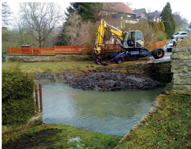
Čištění Zlatého potoka provedlo Povodí Labe, s. p. foto: archiv města Opočna
