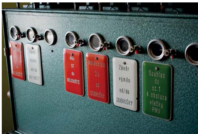
Řídicí přístroj elektromechanického zabezpečovacího zařízení v opočenské železniční stanici. foto: Radka Mecnerová
