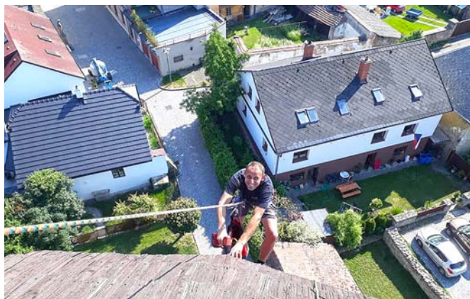
Při opravě střechy zvonice se muselo vylézt do pořádné výšky. Odměnou byla nejen smysluplná práce, ale také krásný rozhled.
