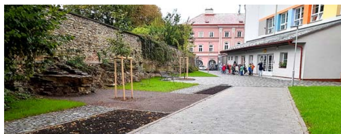
Plochy byly nově vydlážděny, staré dožití stromy pokáceny a nahrazeny novou zelení. foto: Eva Rohlenová
