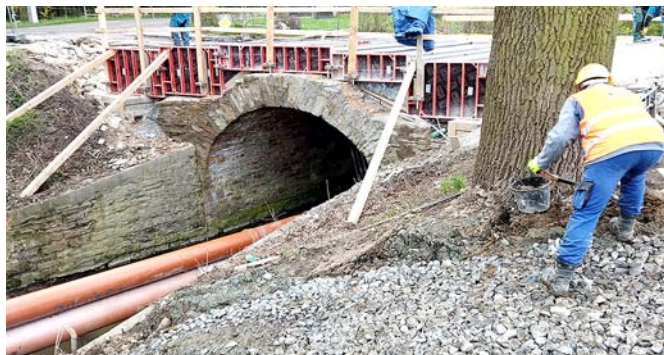
Práce na rekonstrukci hráze jsou v plném proudu. foto: archiv města
