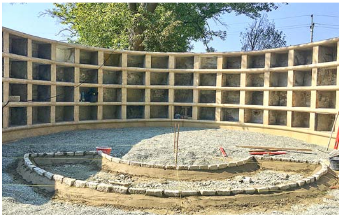
Souběžně s opravou kolumbária probíhají i úpravy zpevněných ploch. foto: archiv města
