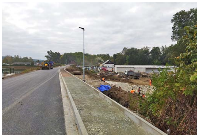
Silnice přes hráz se otevře 1. listopadu.
