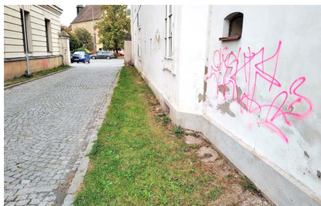
Posprejované fasády domů z pohledu od zimního stadionu směrem na Kupkovo náměstí.
