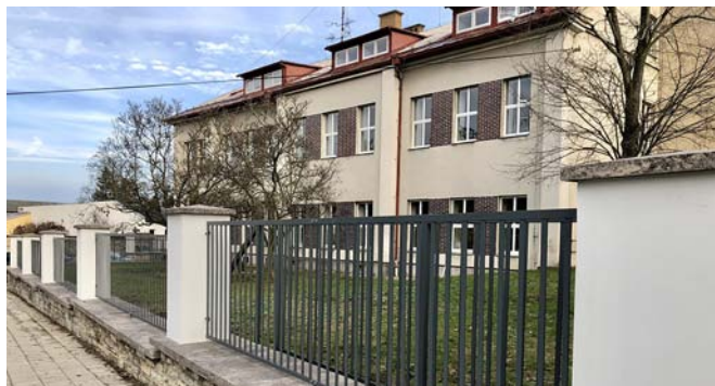
Opravené oplocení areálu bývalé nemocnice
