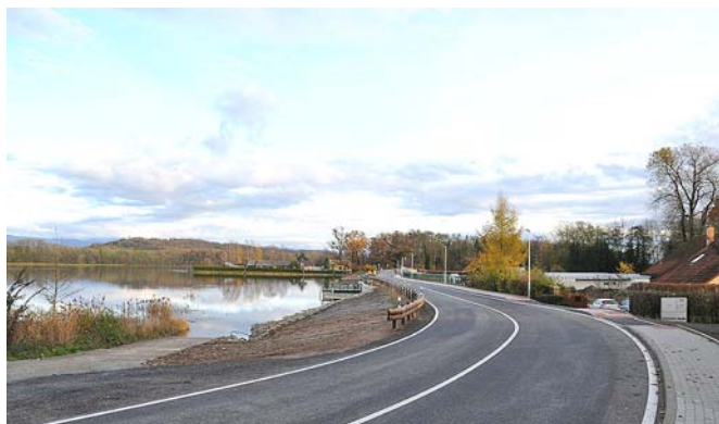
Rekonstrukce hráze rybníku Broumar
