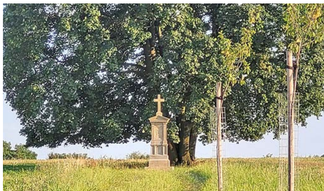
Oprava „Červeného kříže“ v poli, včetně výsadby stromořadí
