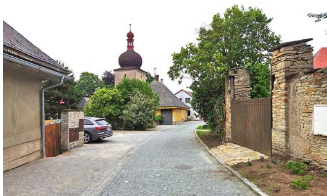
Rekonstrukce Hradební ulice
