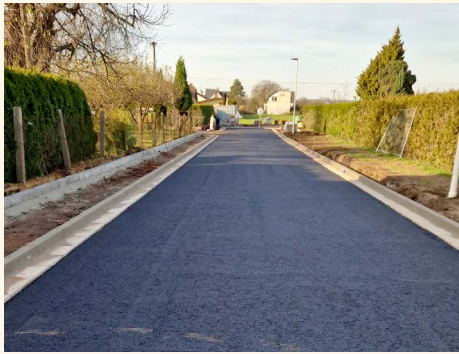
Oprava ulice Procházzkova
