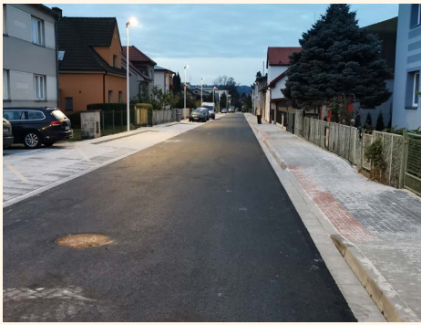
Oprava ulice Fr. Zoubka
