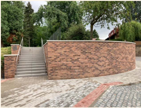
Oprava zdi v Riegrově ulici
