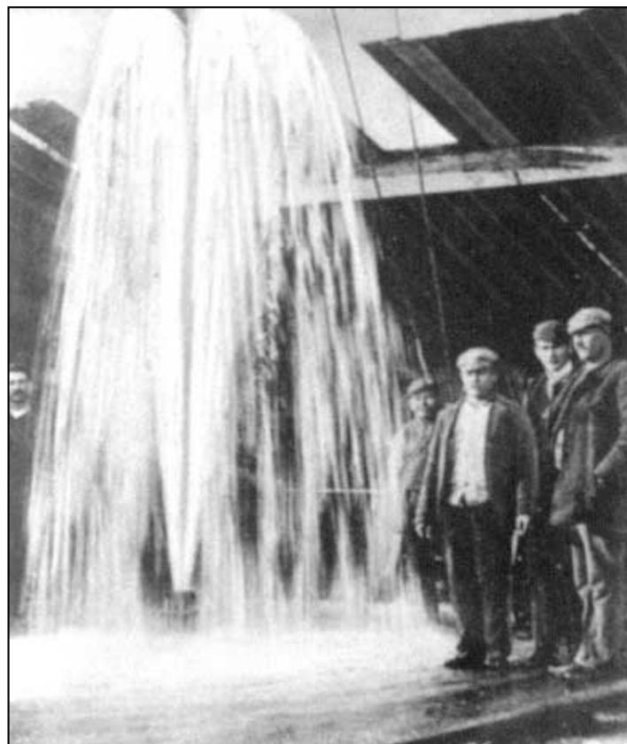
Artézský vrt firmy Thiele u Hradce Králové o hloubce 132 m s denním průtokem 30.000 hl.
