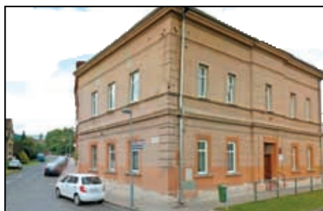
Původní stav MŠ Hornická
