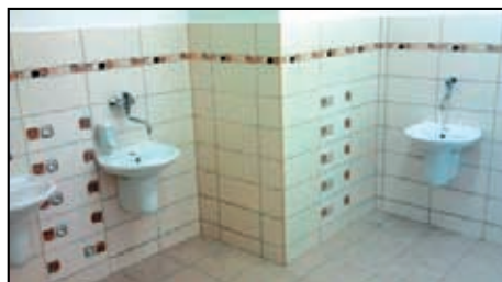
ZŠ Hrdlovská po rekonstrukci
