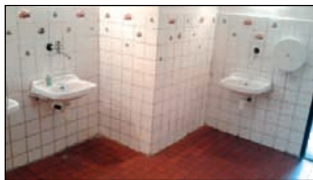
ZŠ Hrdlovská před rekonstrukcí
