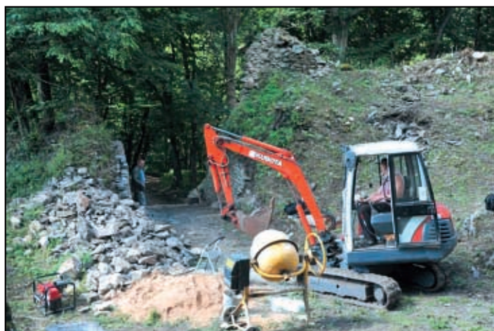
Výstavba můstku a rekonstrukce vstupní brány
