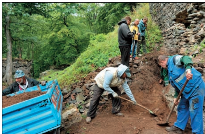
Odkopání paty pilíře a přilehlé kaverny
