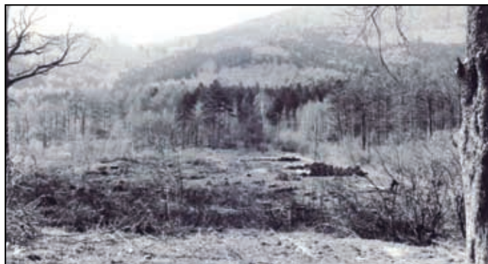
Příprava výstavby sídliště Hrdlovská 2
