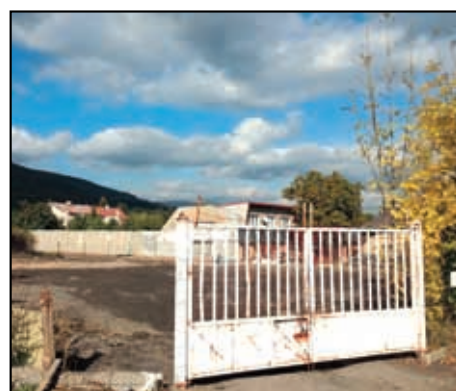
Demolice objektu bývalých stavebnin
