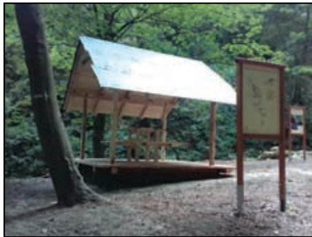
Ještě nedokončený přístřešek
