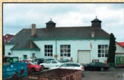
V současnosti sběrný dvůr a zázemí Služeb města Oseka, s.r.o.
