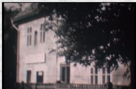
Dům čp. 22, ve kterém byla restaurace „Hrnčířský šenk“
