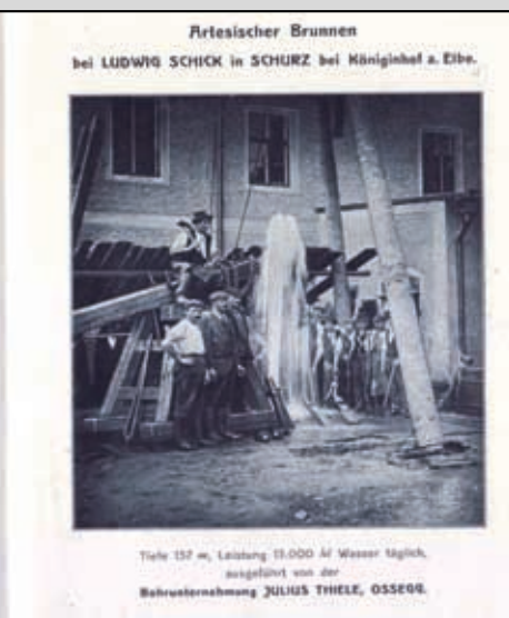
Ukázka úspěšného provedení artéských studní
