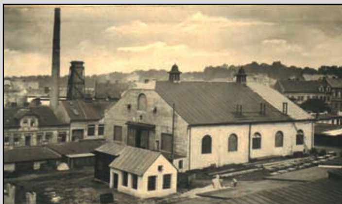
Pohled na dílnu a část hospodářského dvora, vlevo komín a budova kotlární
