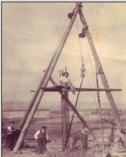
Původní dřevěná vrtná věž
