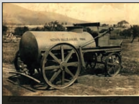
Cisterna na vodu
