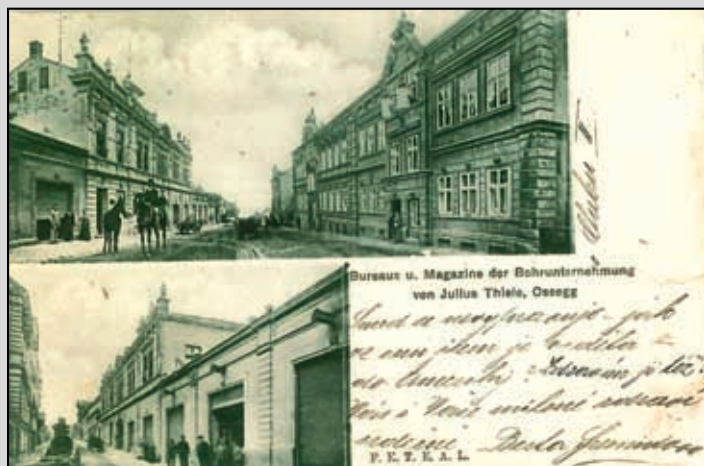
Areál firmy dokončila ještě budova ředitelství ve Slovenské ulici, doplněná sklady s prodejem vrtných a pomocných zařízení.
