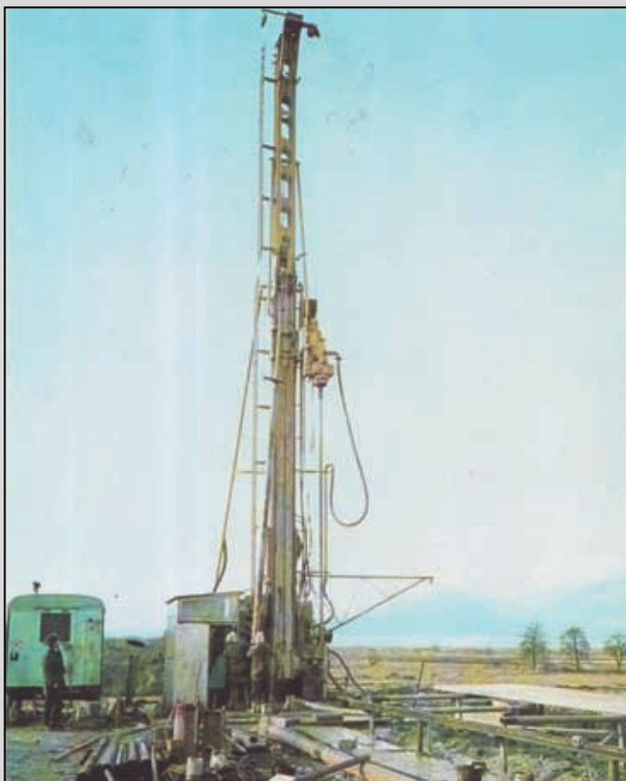
Ke zlepšení práce přispěla i nová vrtná souprava Wirth
