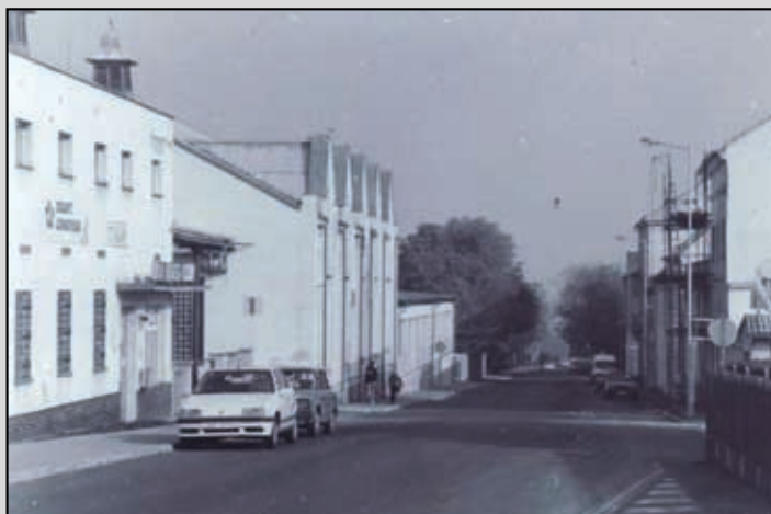
Do firmy je vybudován nový vstup s vrátnicí a sociálním zázemím
