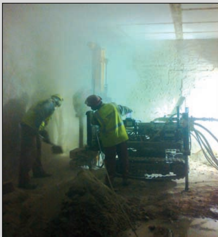
Vrtná souprava HVS 197 Jano - stavba Galerie Teplice 2014
