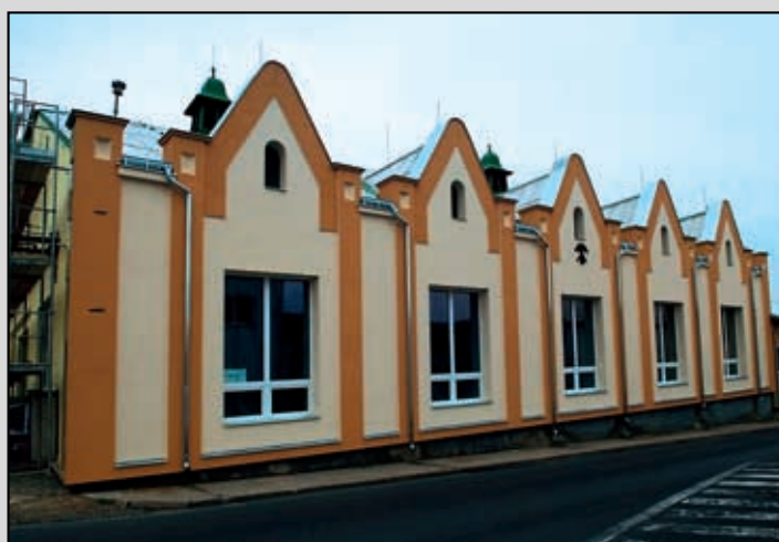
Opravená fasáda dílny
