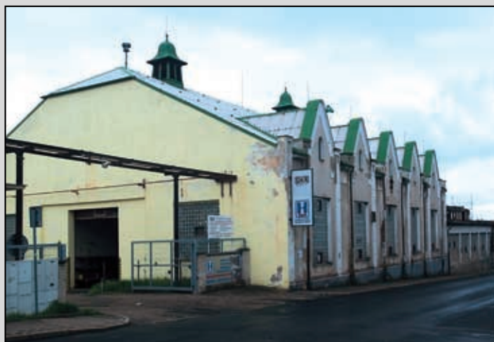
Původní stav dílny před opravou
