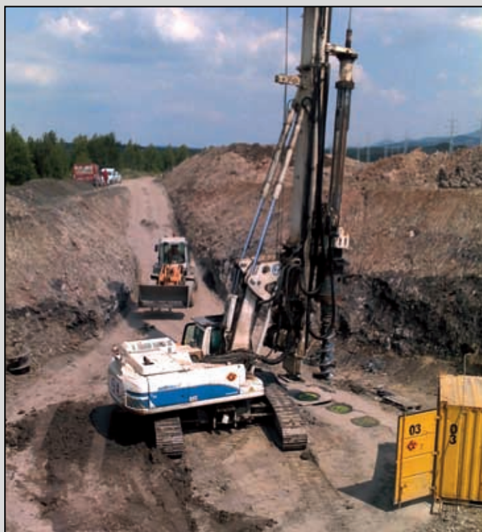
Souprava Soiolmec SR 60 - startovací jáma Doly Bílina 2021
