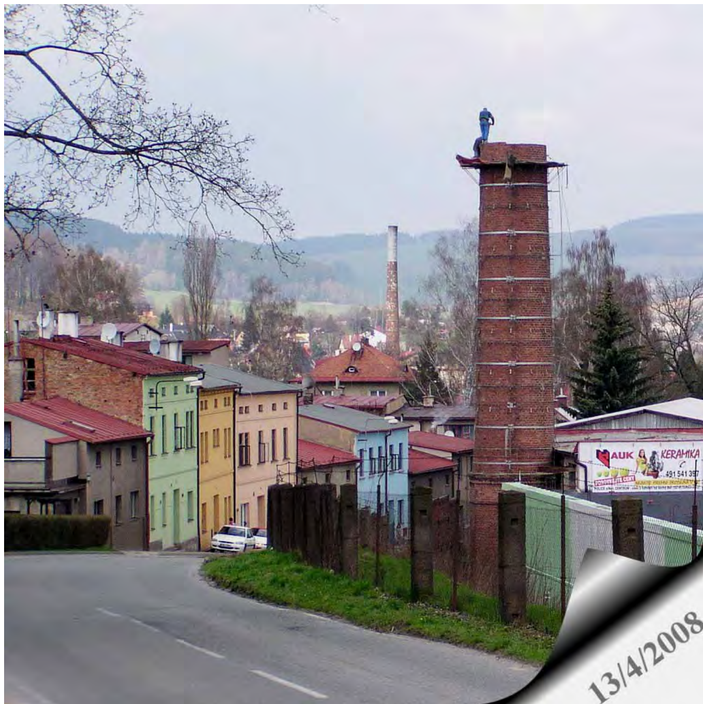
Snímek zachycuje bourání továrního komínu ve firmě HAUK s.r.o. (dříve závod VEBA 10)
