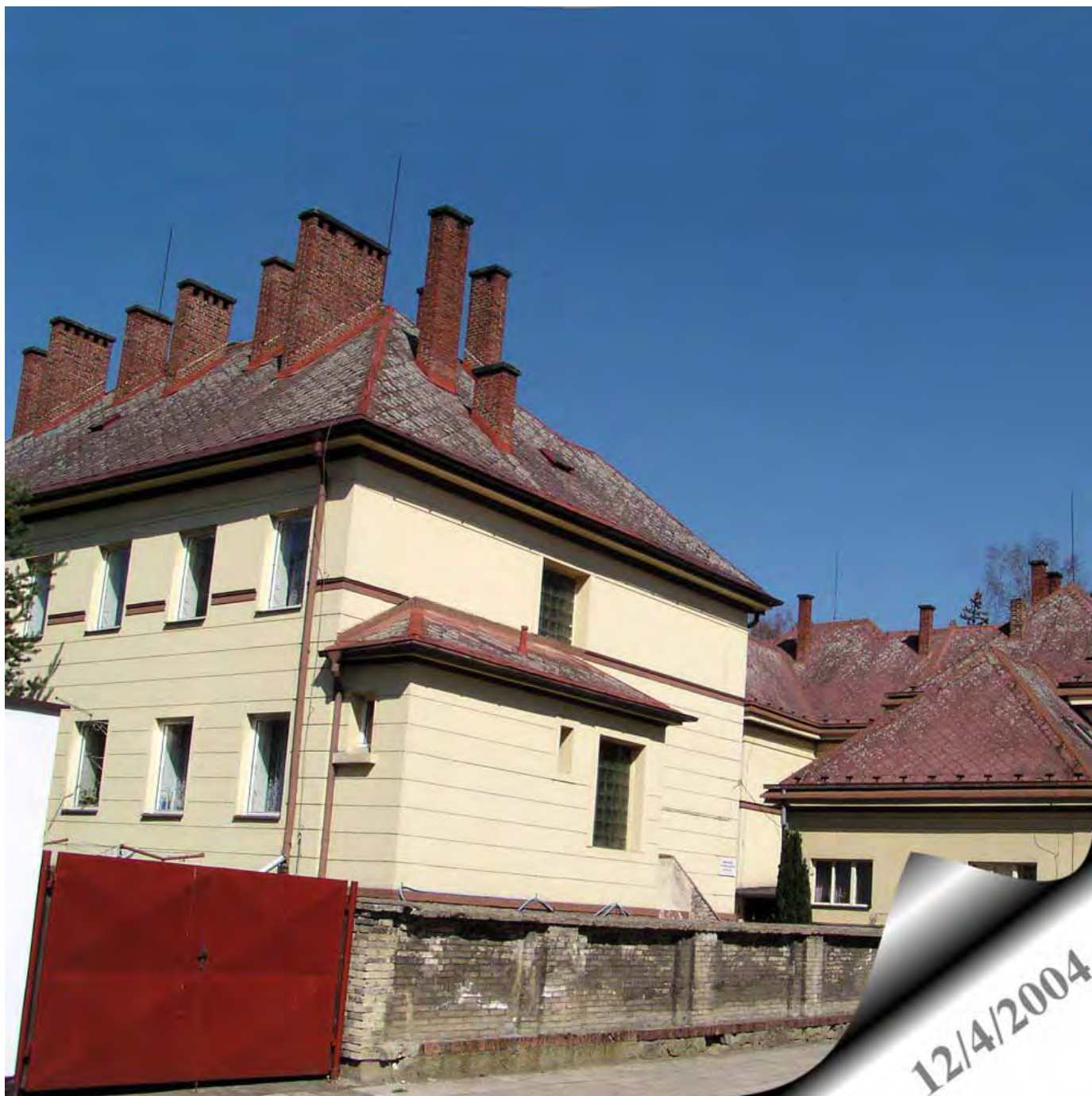
Jedna z budov bývalého středního odborného zemědělského učiliště
