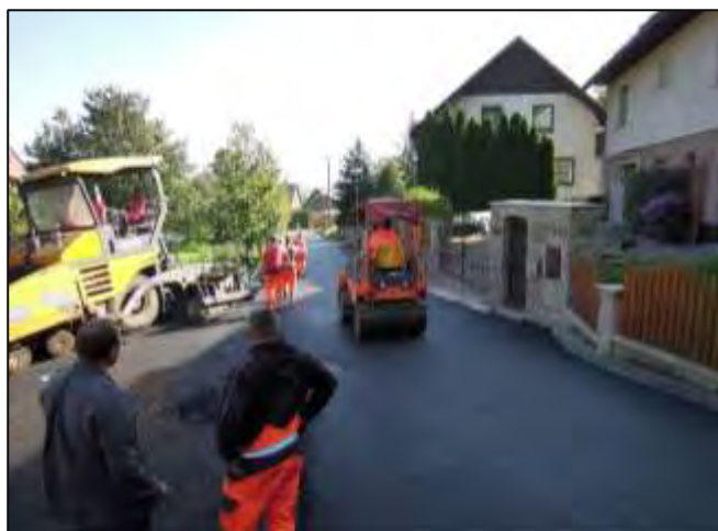
Foto z průběhu výstavby
