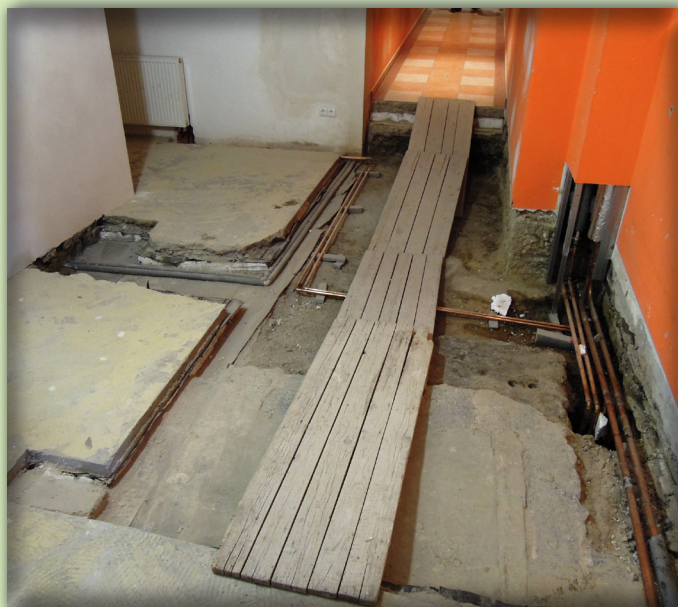
Novému umístění IC je třeba přizpůsobit vytápění a elektroinstalace
