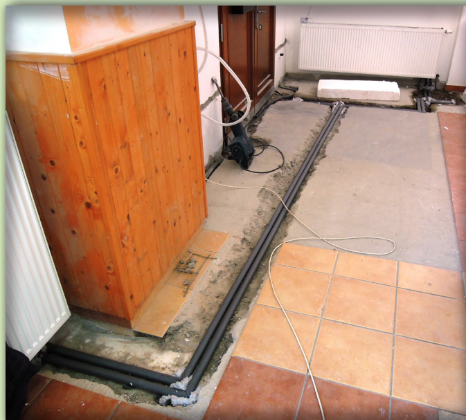
Novému umístění IC je třeba přizpůsobit vytápění a elektroinstalace
