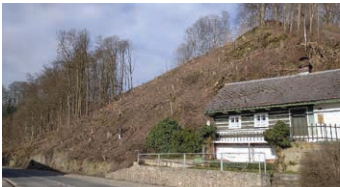
Obr. 1 pohled na vykácenou část Starého parku z údolí od silnice II/303.
