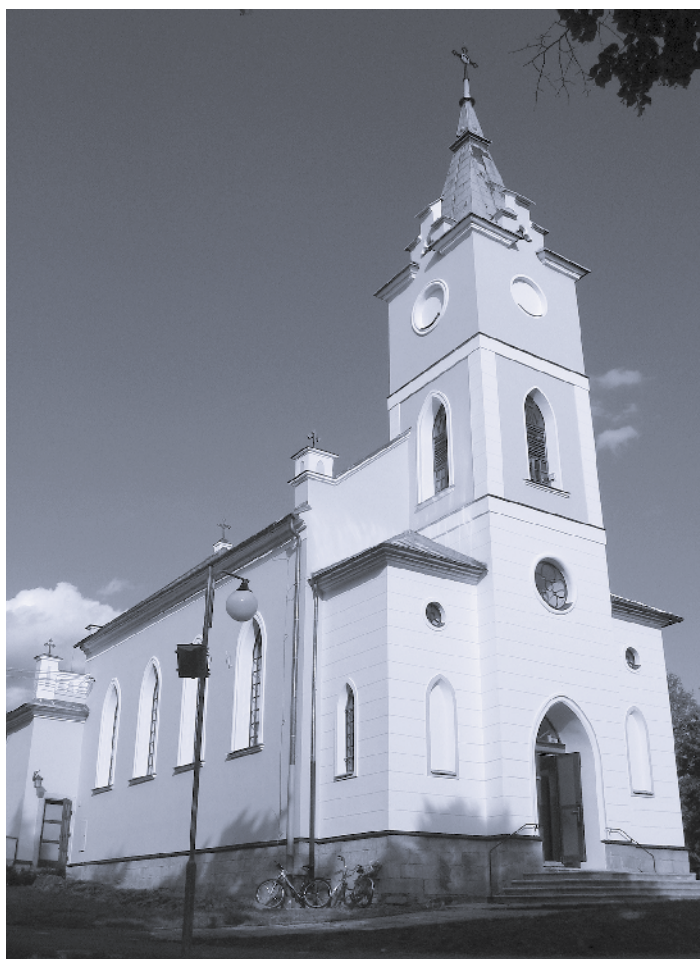
kostel po opravě
