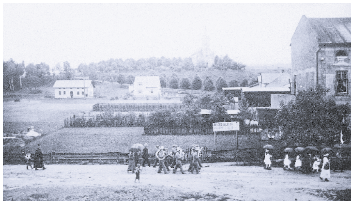
1. Snímek pořízený z náměstí, vpravo nejbližší rohový dům s dnešní prodejnou pana Skořepy, vzadu pěkně viditelný, stromy nezakrytý kostel, pod ním dům Hubkových, vlevo dům Paštálkových.
