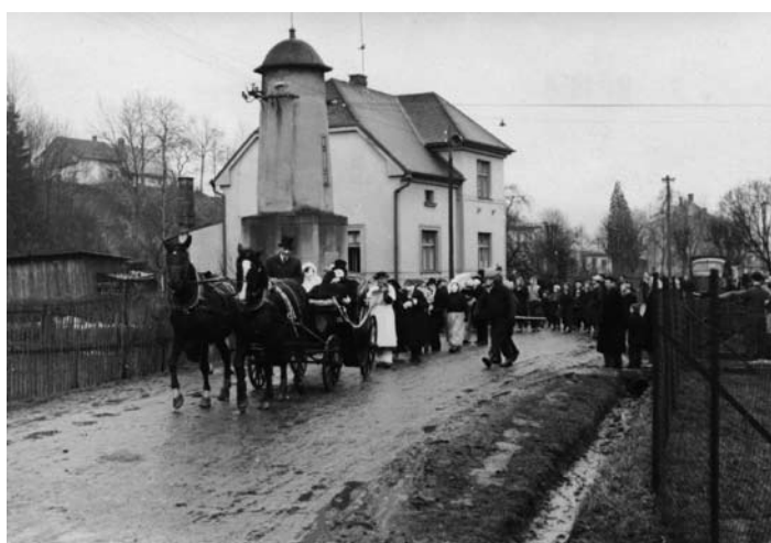
2. u pana Roubala (transformátor již zde není)
