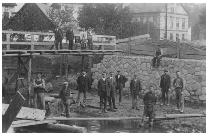
1. Stavba mostu „U zrcadla“ v roce 1924. V pozadí Maršíkův dům.
