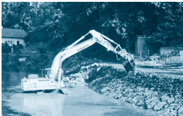
Práce bagristy na záhozu v zátočině Metuje podél ulice Za Řekou
