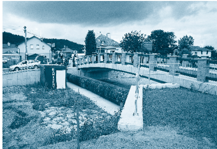
Zprovozněný vak za mostem Na Ostrov bude regulovat odtok části velké vody z řeky Metuje do průlehu na malá luka.
