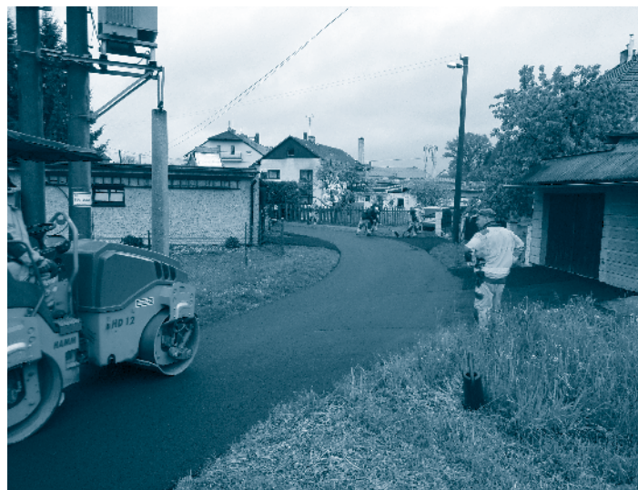
Oprava komunikace v ulici „u Lantů“ (prodejna Barev).
