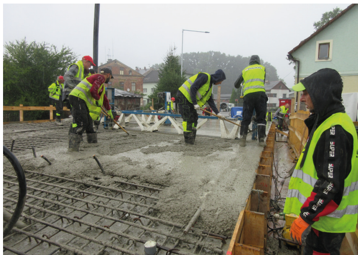
Betonáž mostovky, autor fotografie Václav Cvejn
