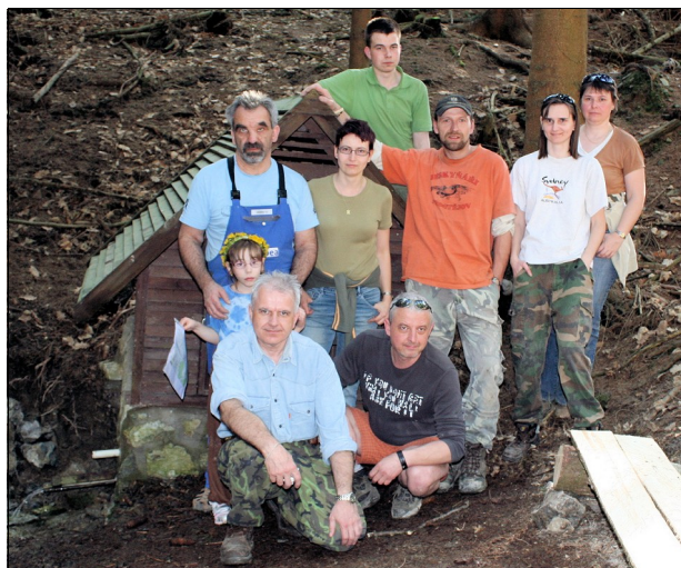
po opravě studánky Nad Sauklovým mostkem (3914)
