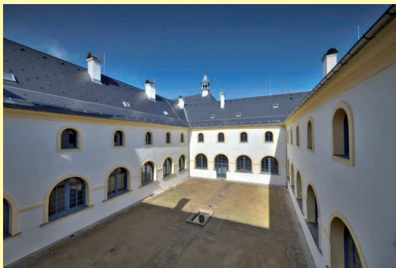
Nově opravený františkánský klášter v Hostinném získal ocenění Stavba roku 2012.
