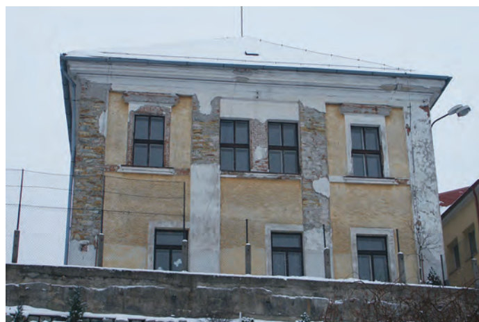
V letošním roce začne rekonstrukce budovy školy v Kolowratské ulici
