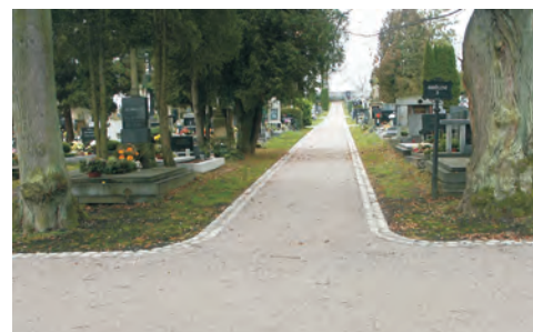
Nová úprava cest na hřbitově. Foto: man
