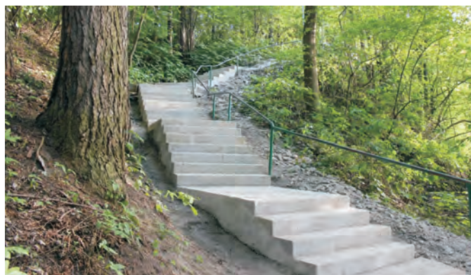
Oprava schodů v Modřinkách.
