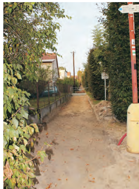
Rekonstrukce chodníku Nad Zvonící.
