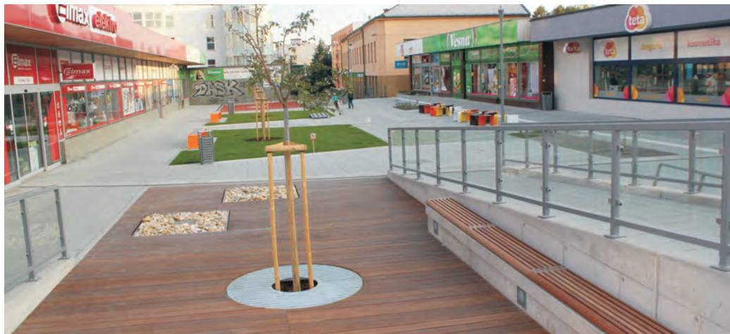
Druhá fáze rekonstrukce Havlíčkovy ulice je ukončena. V poslední, třetí fázi, vznikne fontána i pítko.
