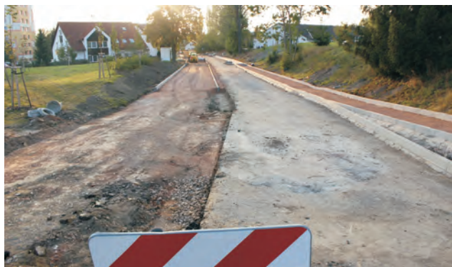
Nové vznikající parkoviště pod plaveckým bazénem.
