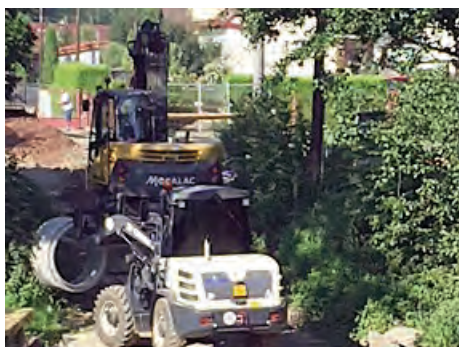
Fotografie z výstavby kanalizace.
