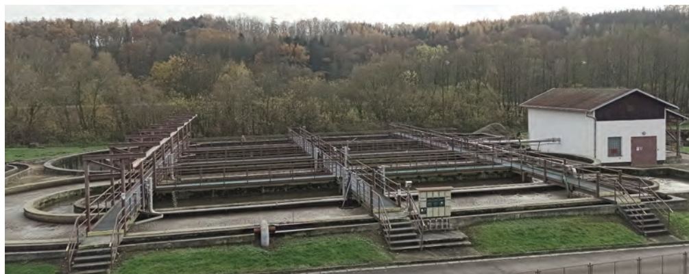
Čistírna odpadních vod v Rychnově nad Kněžnou určená k rekonstrukci. Foto: Vak RK
