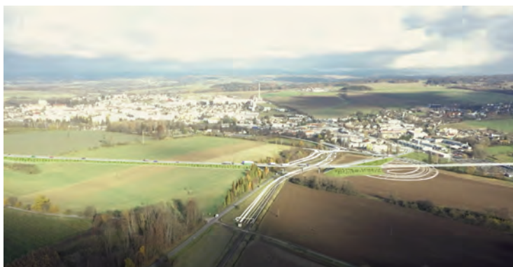
Dva snímky obchvatu u Zbuzan včetně napojení na Budín, které je plánováno v další etapě budování obchvatu.
