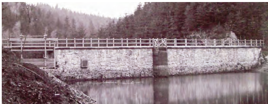
Přehrada Ivanského jezera je 7 metrů vysoká. Byla postavena na Javornickém potoce v roce 1907 jako ochrana před povodněmi.
