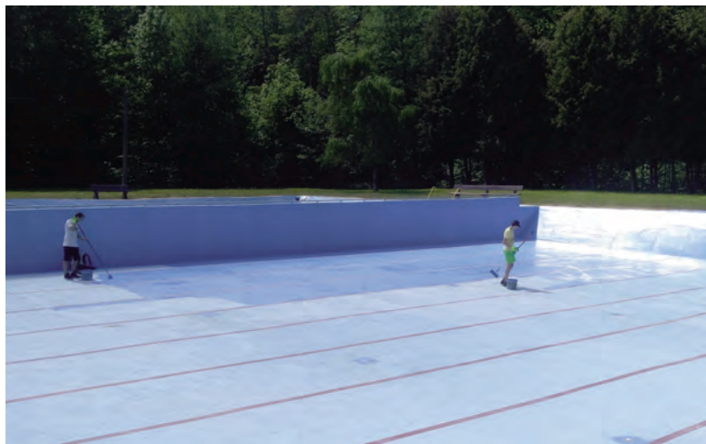
Práce na přípravě koupaliště ve Včelném jsou v plném proudu.
