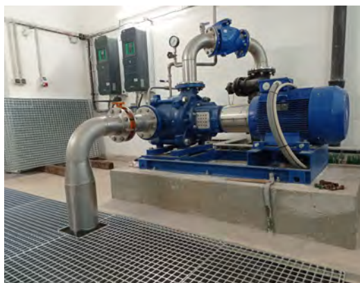
Výstavba automatické tlakové stanice Průhon - stav PŘED a PO DOKONČENÍ.
