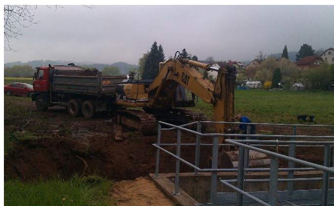
Stavba ČOV na Jestřebci už začala.
