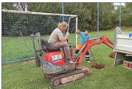
Výkop děr pro nové brány
