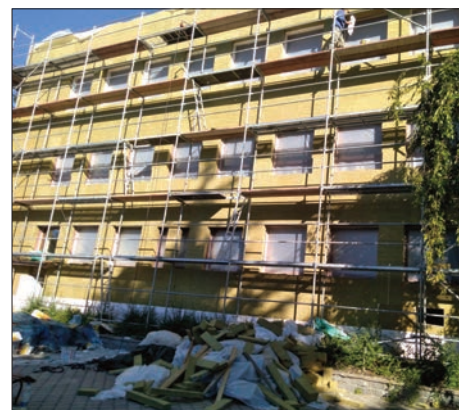
Práce na zateplování budovy MŠ
