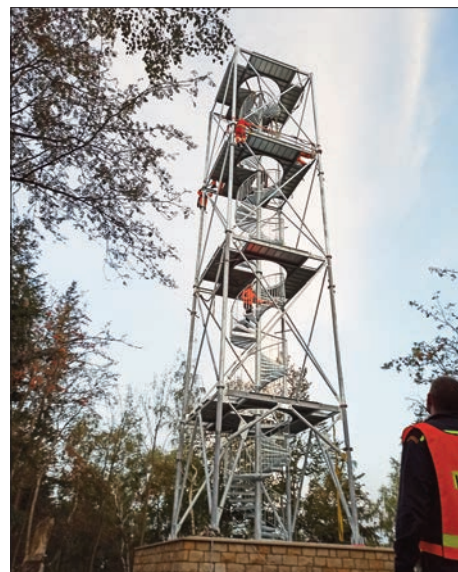
Dohled a zabezpečení při stavbě nové rozhledny Žaltman
