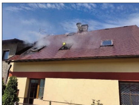
Z výjezdu č. 25 – požár rodinného domu ve Velkých Svatoňovicích
