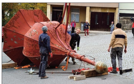
Báň určená k rekonstrukci
