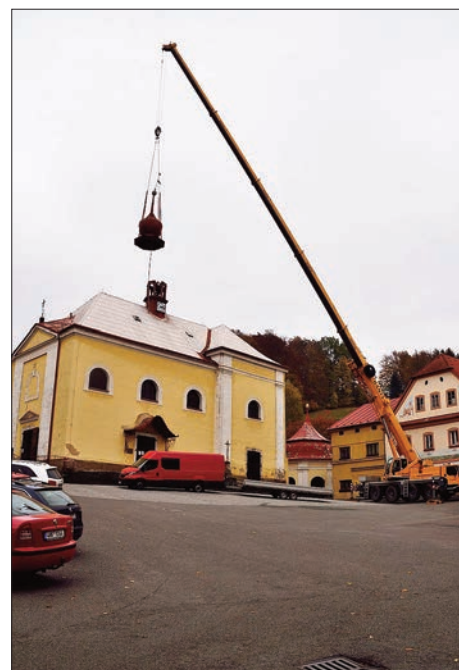
Demontování poškozené části věže
