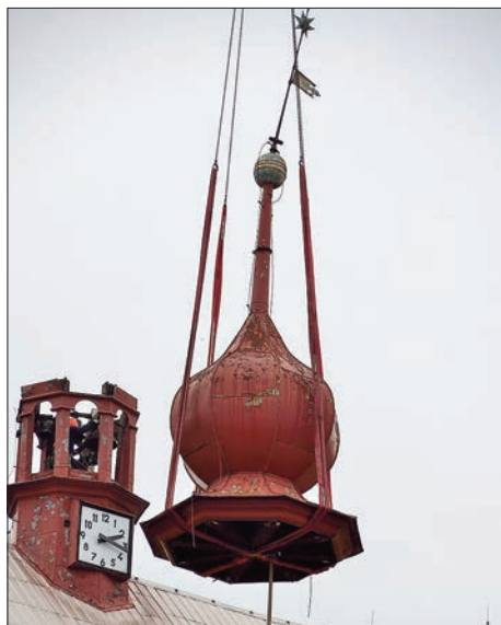
Detail z demontování věže
