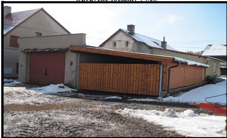
Přístřešek pro techniku
