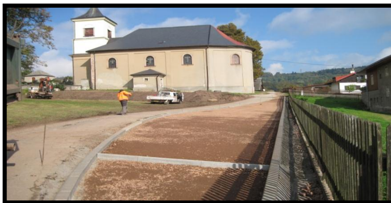
Úpravy u hřbitova v Markoušovicích
