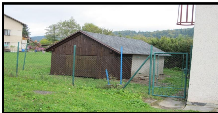
Opravená střecha nad vrtem
