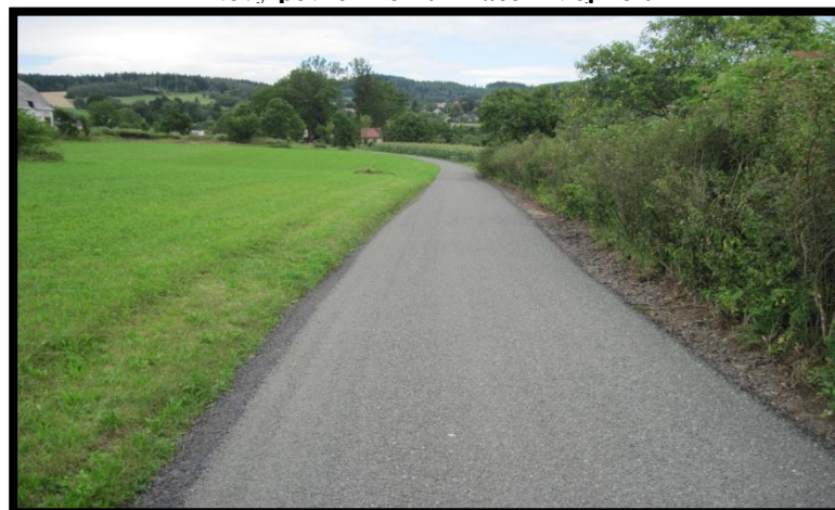
Komunikace pod kravínem
