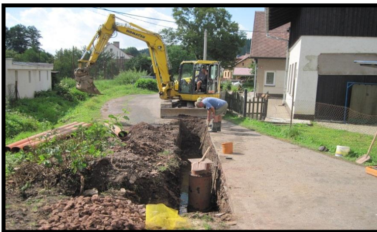
Budování kanalizace za tělocvičnou
