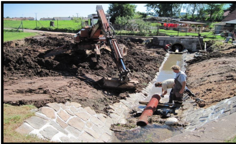
Vyzdívání nového koryta bývalé nádrže
