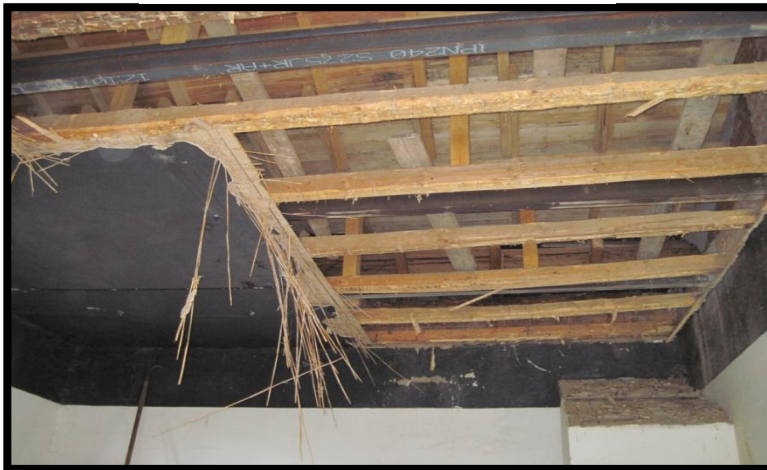
Odstranění původního stropu v KK
