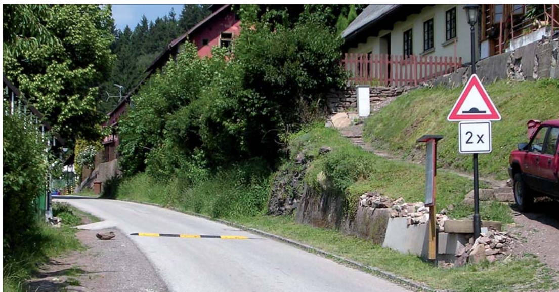
V Horské ulici, byly v minulých dnech nainstalovány zpomalovací prahy a zároveň byla omezena rychlost na 30 km v hodině.
