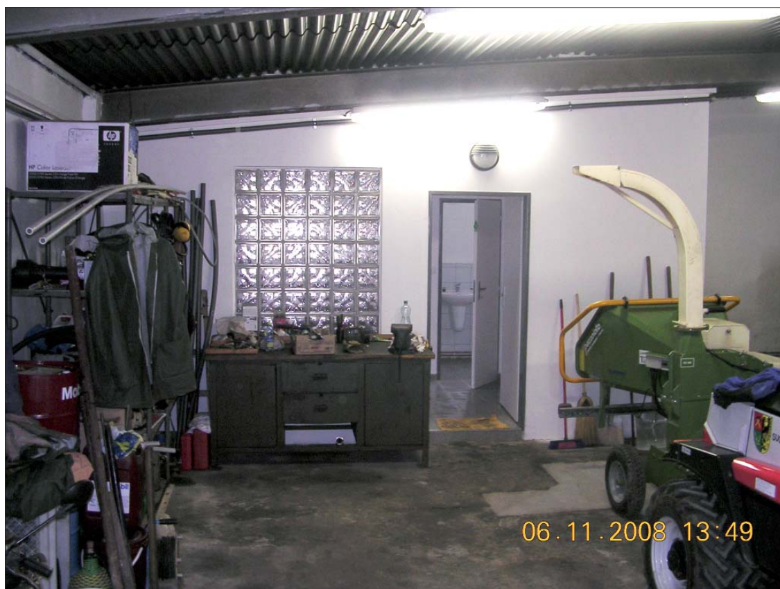
Rekonstrukce městských garáží – vodovodní přípojka, vytápění, kancelář a sociální zařízení.
