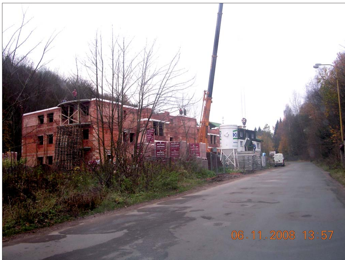
Výstavba 36 bytových jednotek v Lázeňské ulici.
