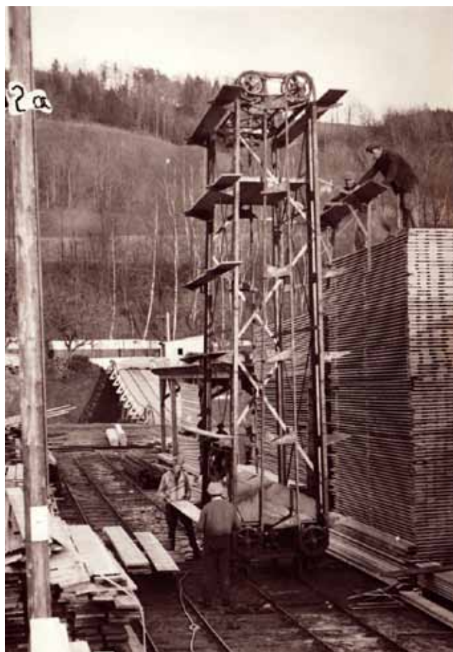
Důmyslné zařízení na rovnání prken do hrání * Dopravní smyky s úložištěm kmenů
