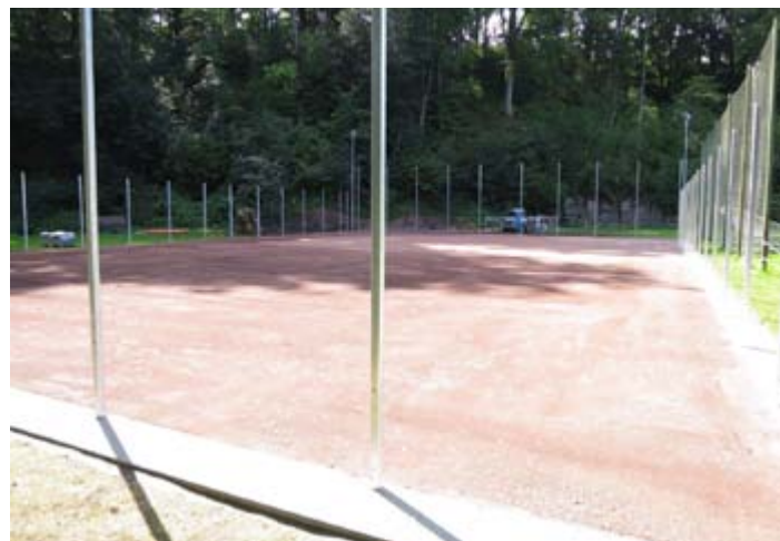
Výstavba Víceúčelového hřiště na městském stadionu
