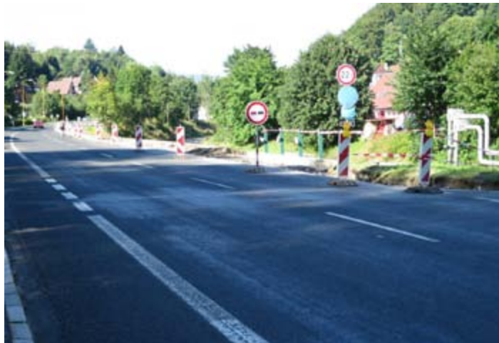
Výstavba chodníků a přechodů pro chodce v Maršově II
