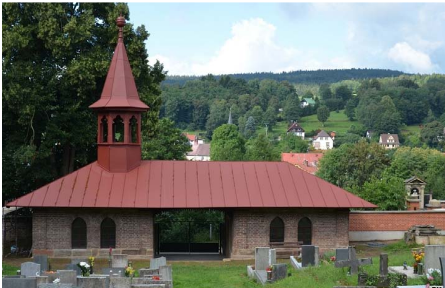
Opravená márnice na svobodském hřbitově
